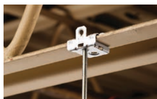
Tige filetée/chaîne/câble sur poutre acier
