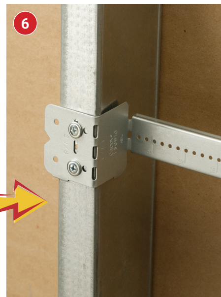
6. Installera TSGB mot staget med produkt nr 187197 lågprofilskruv.
